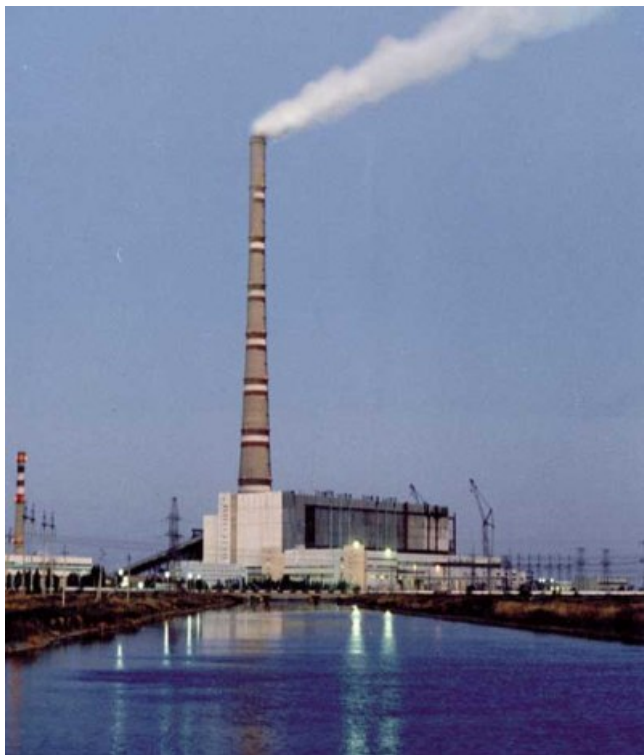
Одна из самых высоких в мире (H=440 м.) дымовая труба Экбастузской ГРЭС. Расчет Фундамента выполнен Сотрудниками и аспирантами кафедры строительной механики ЮУрГУ методом В.И. Соломина. Расчет был выполнен по заказу ВНИПИ Теплопроект Минмонтажспецстроя СССР.
